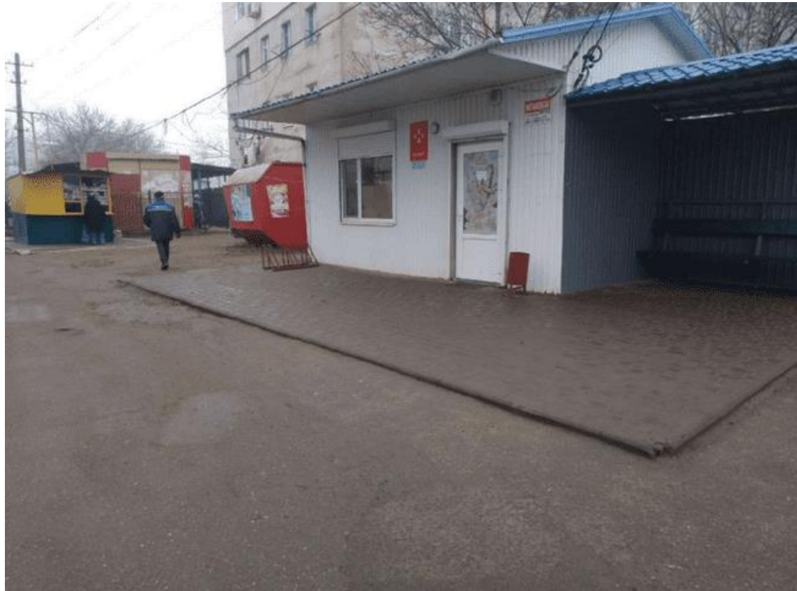
Рис.2. Зупинка по вул. Садова
