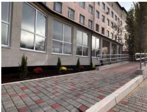
Приймальне відділення Біляївської Багатопрофільної лікарні після ремонту.
