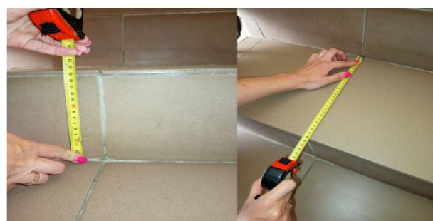
**12) перед перешкодами, що становлять небезпеку для осіб з порушенням зору, а також паралельно до сходів, перед і після сходового маршу розташована попереджуvalьна тактильна смуга\***
