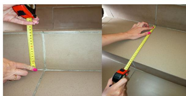
**4) перед перешкодами, що становлять небезпеку для осіб з порушенням зору, а також паралельно до сходів, перед і після сходового маршу розташована попереджуvalьна тактильна смуга\***
